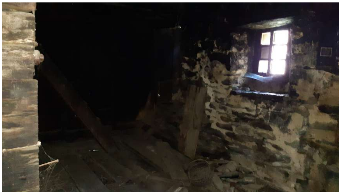
Foto 3-4-5 – unità abitativa lato dx, piano primo
