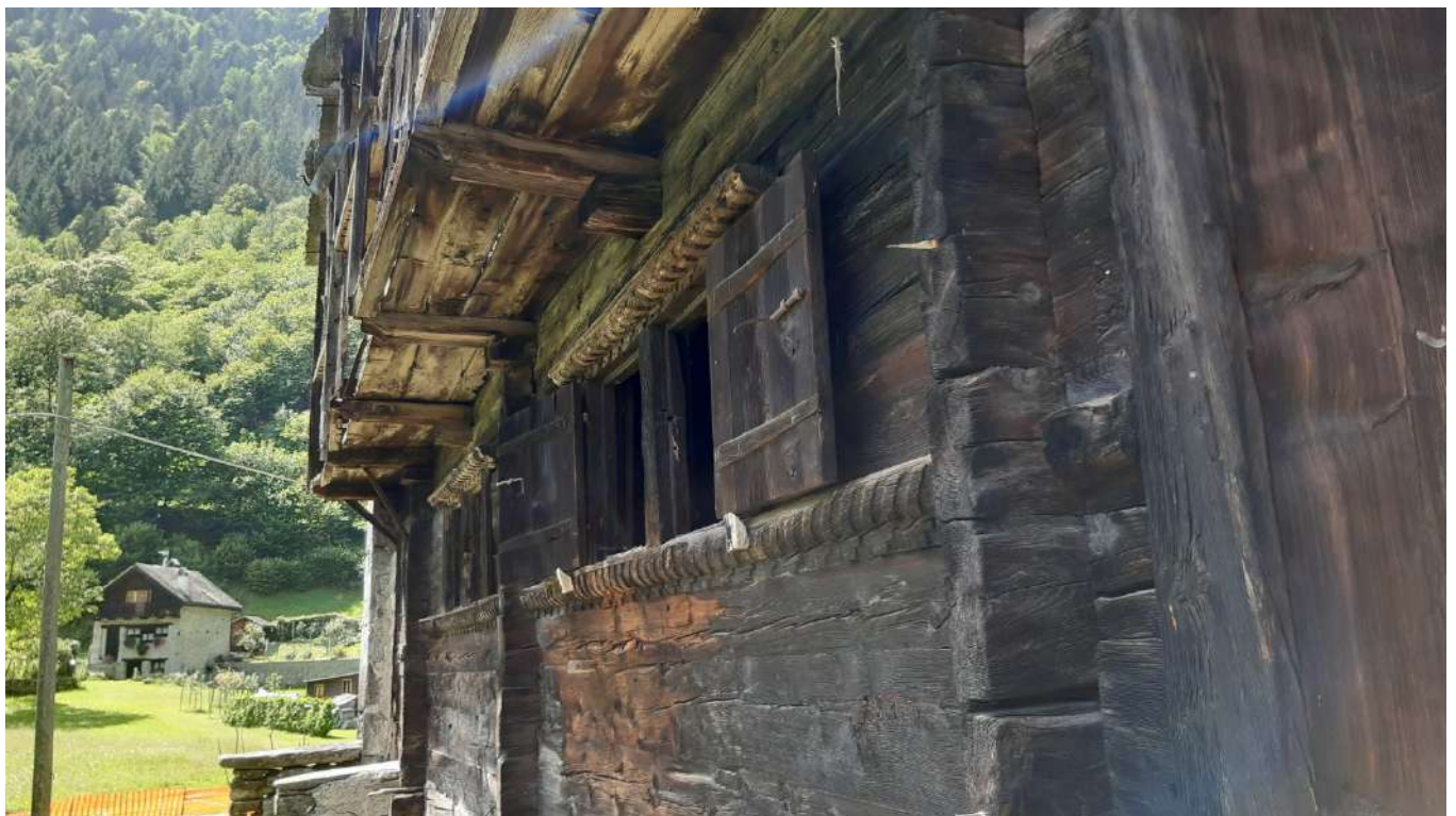
Foto 7 e 8 – particolari aperture all'altezza del piano primo, , prospetto sud
