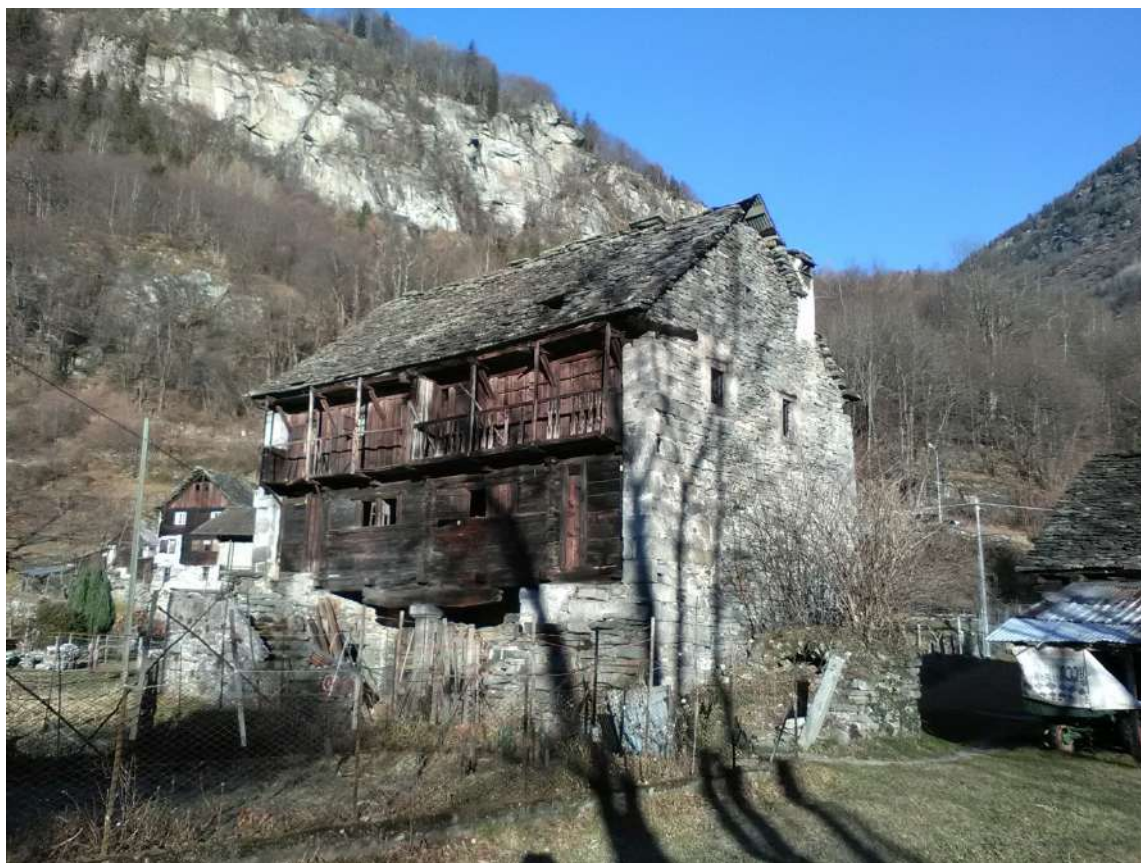
Foto 2 – Vista prospettica del fabbricato, da sud-est
