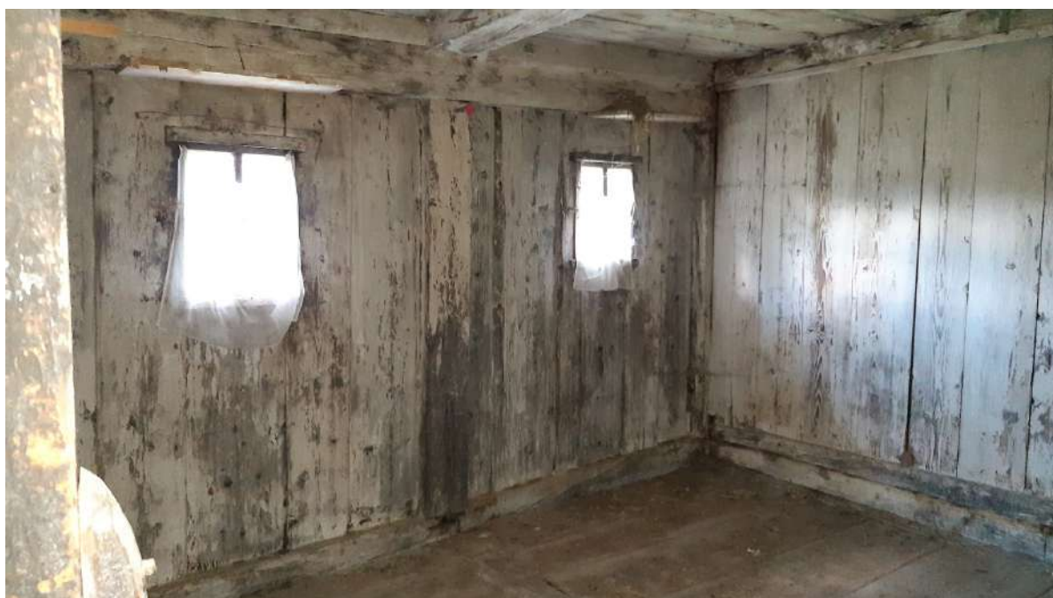
Foto 11 – camera in unità abitativa lato sx, piano secondo
