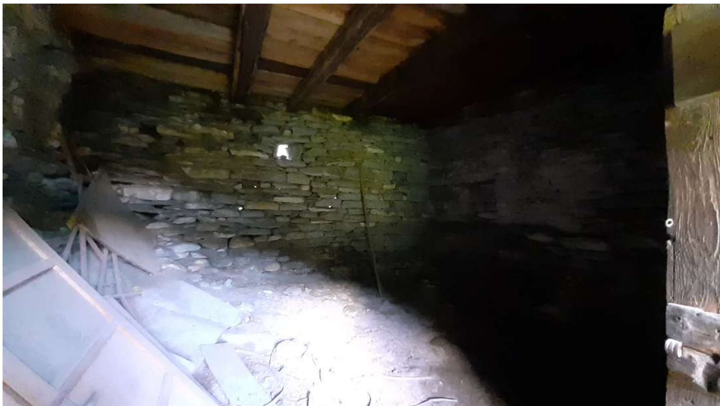
Foto 1 – locale al piano terra, lato dx
