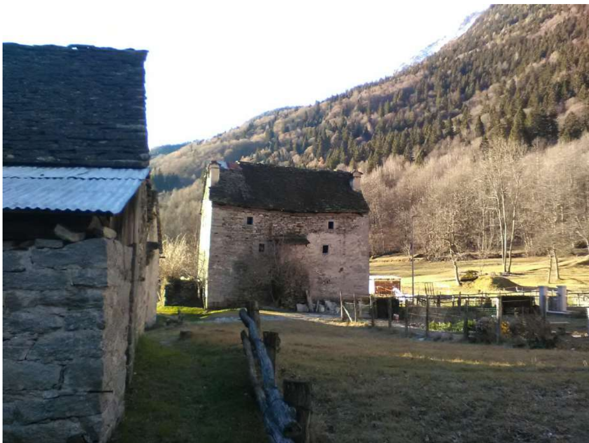
Foto 3-4 – Vista della facciata posteriore, da nord
