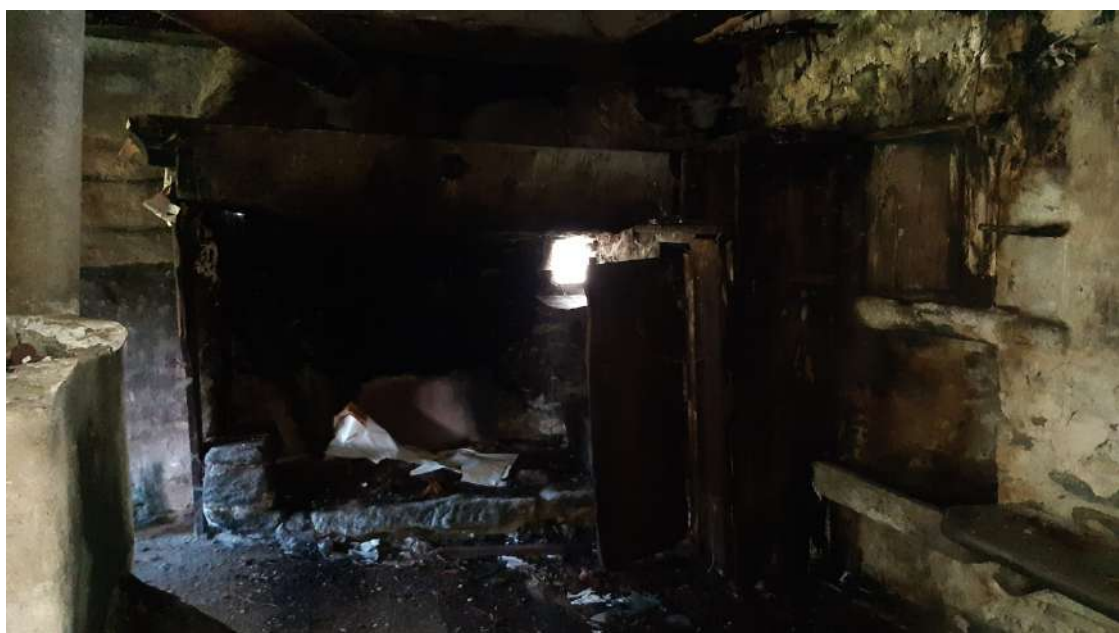
Foto 6-7-8 – unità abitativa lato sx, piano primo
