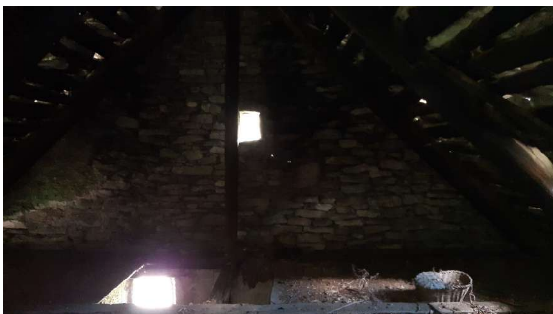
Foto 15-16-17 – vano sottotetto al piano terzo
