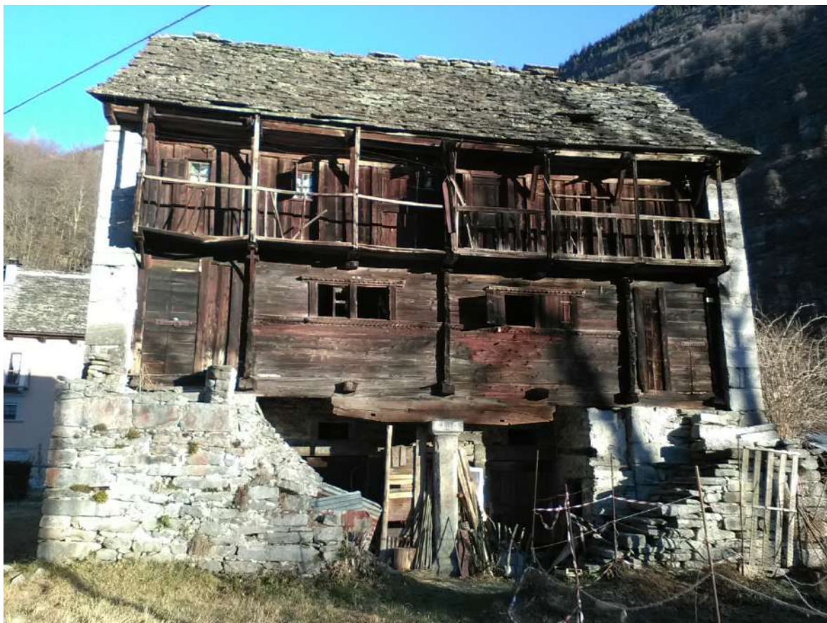
Foto 1 – Vista della facciata principale, prospetto sud
