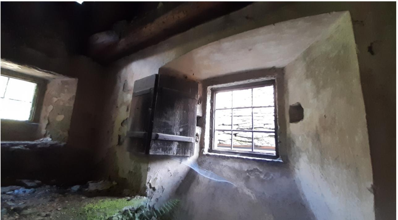
Foto 6 – dettaglio apertura con scuro interno ad anta, su vano scale
